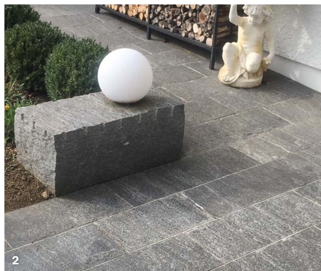
1 Onsernone-Gneis (TI): Platten gesägt in freien Längen, Oberfläche geflammt, in Bahnen verlegt auf Splitt (ungebundene Bauweise), Fugen offen mit Fugenkreuzen 2 Calanca-Gneis (GR): Oberfläche bruchroh, gebundene Bauweise, in Bahnen verlegt und mit Fugenmörtel verfugt.
