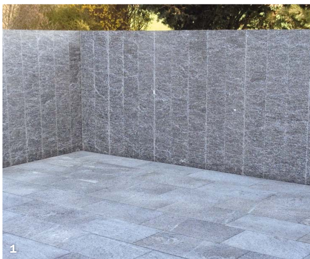
1 Onsernone-Gneis (TI): Platten gesägt in freien Längen, Oberfläche geflammt, in Bahnen verlegt auf Splitt (ungebundene Bauweise), Fugen offen mit Fugenkreuzen 2 Calanca-Gneis (GR): Oberfläche bruchroh, gebundene Bauweise, in Bahnen verlegt und mit Fugenmörtel verfugt.
